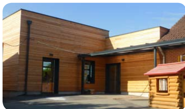
Extension destinée au restaurant scolaire et à la garderie
